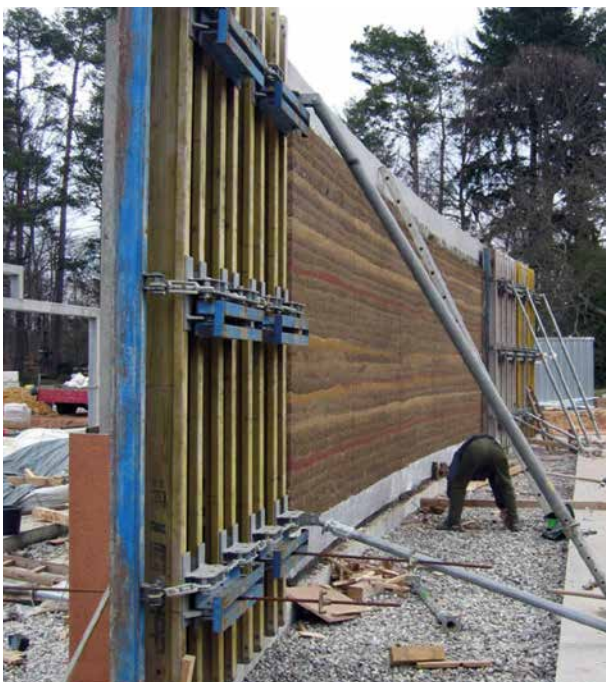
Abb. 1.1.1: Vor-Ort-Ausführung einer Stampflehmwand mit stabiler Schalung
