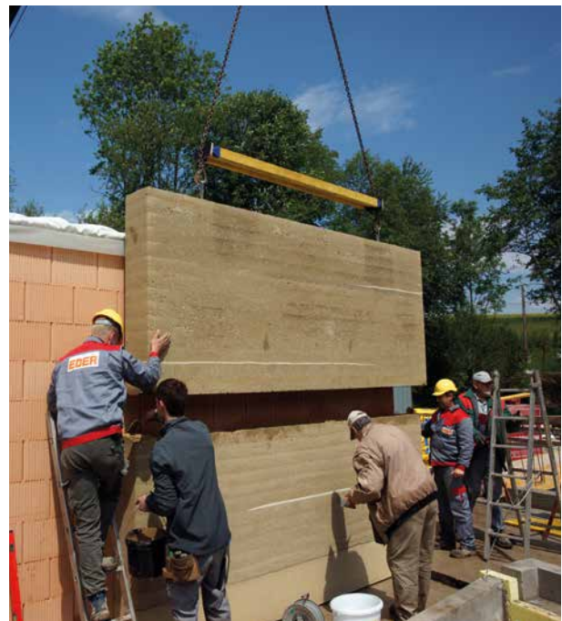
Abbildung 1.1.2: Montage eines vorgefertigten Stampflehmelements auf der Baustelle.
