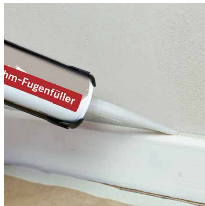
Fugenfüllung mit natur-weiß an einer Sockelleiste
