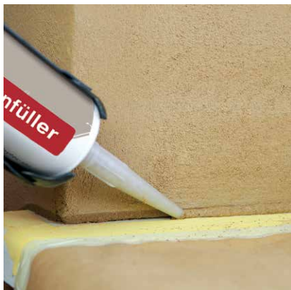
Fugenfüllung mit natur-braun an einer Fensterbank
