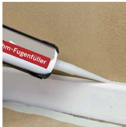
Voegvulling met natuur-licht aan een lambrisering
