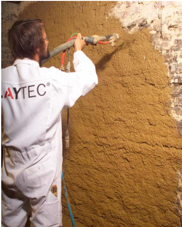
Abbildung 6.1.1: Anspritzen von Lehm-Grundputz auf Ziegelmauerwerk mit der Putzmaschine
