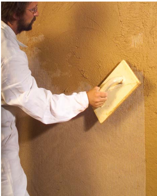
Abbildung 6.1.3: Sorgfältiges Einarbeiten der Armierung mit dem Schwammbrett
