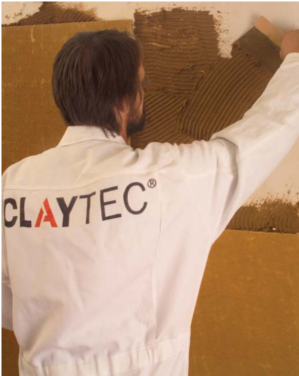
Abbildung 5.3.1: Aufziehen von Lehmkleber mit dem Zahnschachtel auf die vorbereitete Fläche
