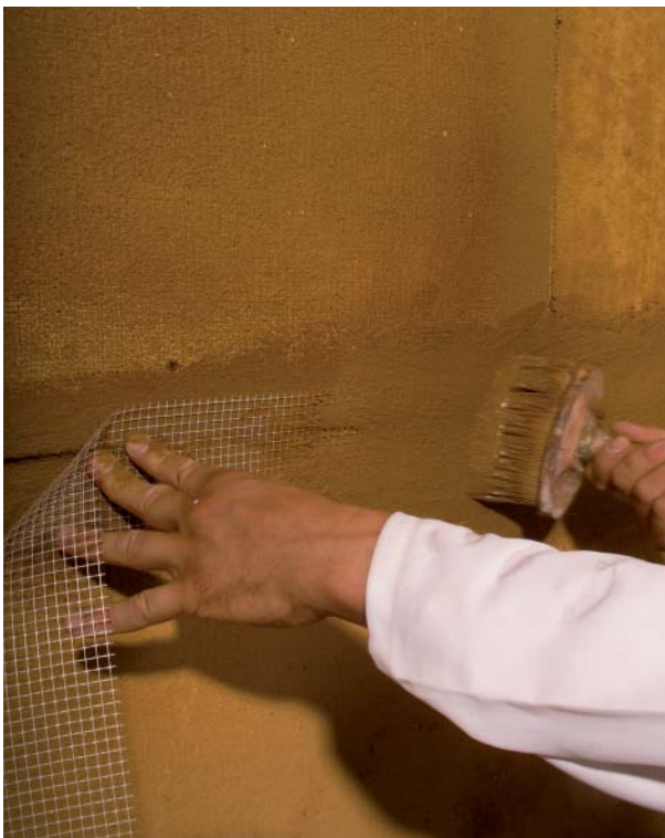
Abbildung 5.3.3: Einarbeiten von Flächen- oder Fugenarmierung (hier Glasgewebe-Fugenarmierung)
