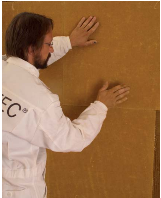
Abbildung 5.3.2: Ansetzen der Lehm-Trockenputzplatten D16 unmittelbar nach Aufziehen des Klebers
