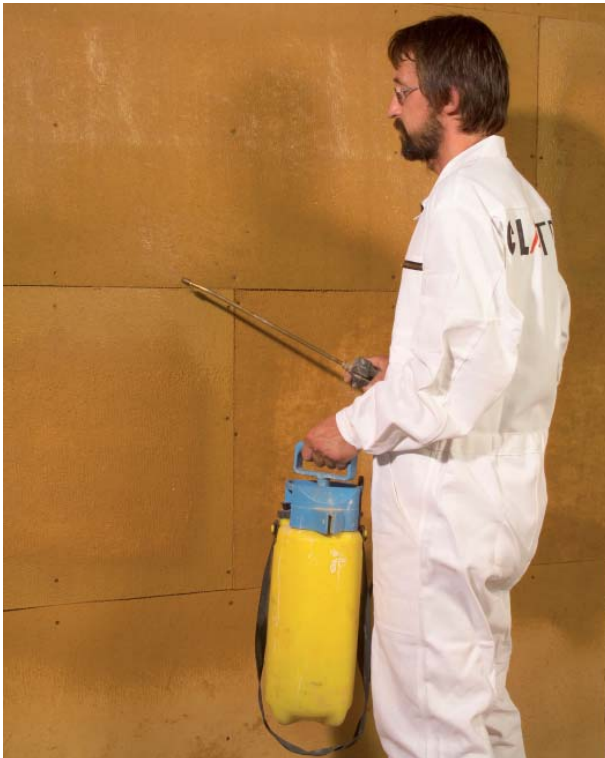
Abbildung 5.2.4: Vornässen der Fugenbereiche der Lehm- bauplatten per Sprühnebel
