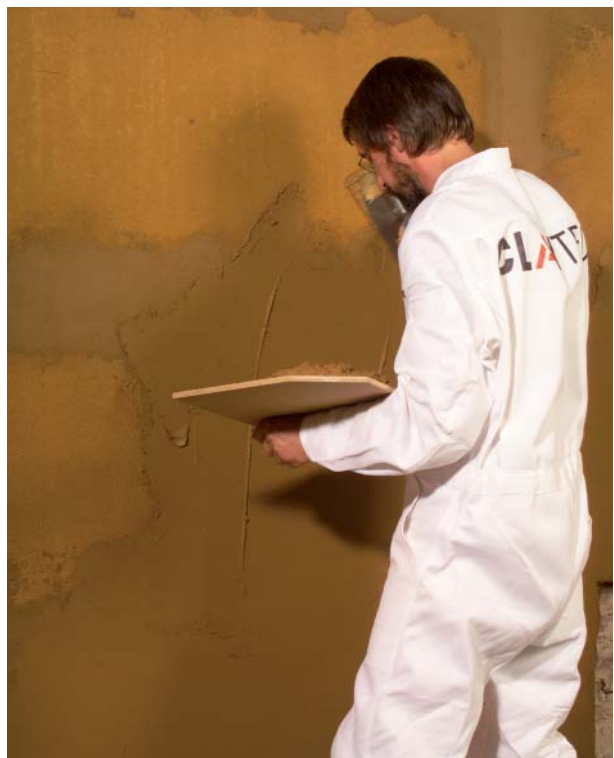
Abbildung 5.2.7: Überspachteln der gesamten Fläche mit Claytec Lehm-Oberputz fein
