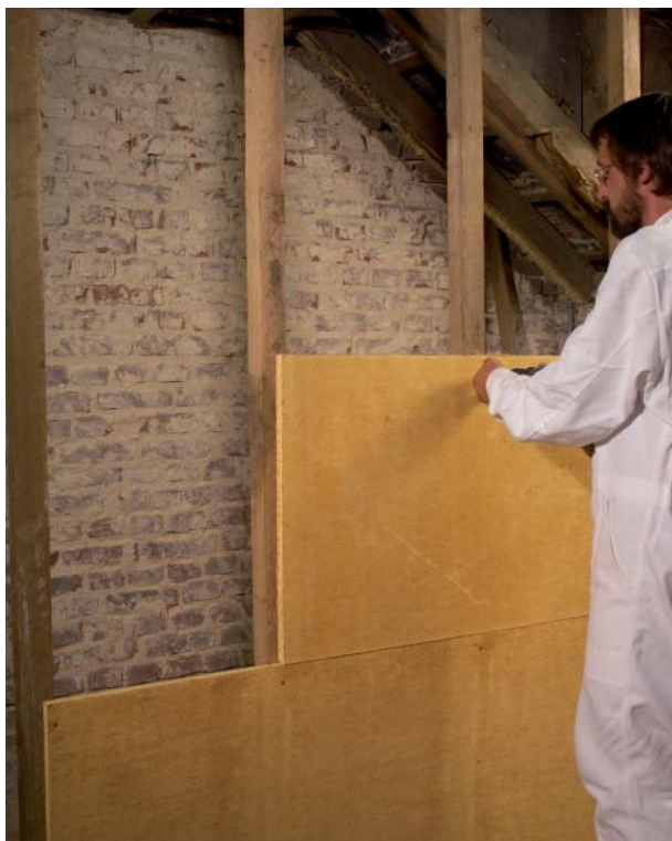
Abbildung 5.2.1: Montage der Lehm- bauplatten am Pfosten- werk einer Ständerwand/ Vorsatzschale
