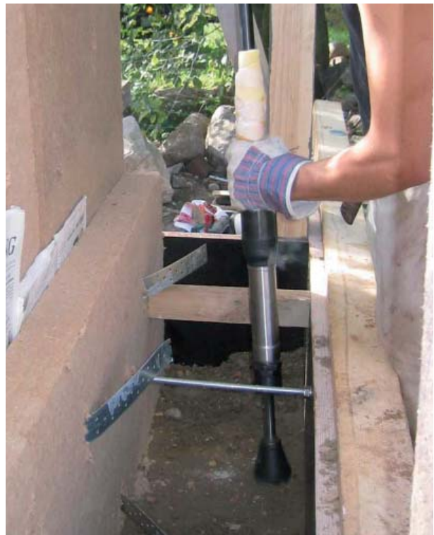
Abbildung 1.1.2: Der Kleinstampfer ermöglicht auch das sorgfältige Verstampfen kleinräumiger Bauteilbereiche.
