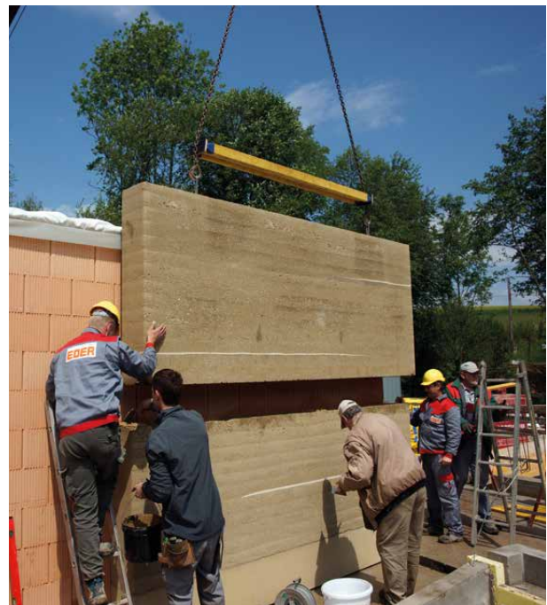
Abbildung 1.1.2: Montage eines vorgefertigten Stampflehmelements auf der Baustelle.
