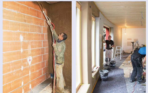
▲ Lehmputze im Institut für Baubiologie + Nachhaltigkeit IBN links: maschinelles Aufbringen von Lehm-Unterputz auf eine Ziegelwand. rechts: Aufbringen eines Lehm-Dünnschichtmörtels auf einen Lehm-Unterputz.
