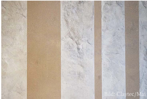
Wandgestaltung aus geriebenem Feinputz und geglä- teter Lehmfarbe ▶
