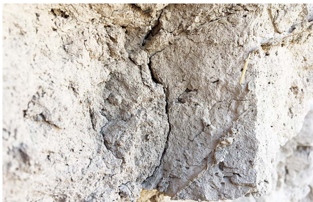
Uruk, Irak, ca. 5.000 Jahre alter Häcksel in einem Strohlehmbauteil
