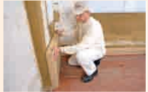
4 Ansetzen von Holzfaserdämmplatten auf dem Untergrund.
