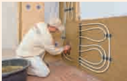
6 Wandflächenheizungen werden häufig mit Innendämmungen kombiniert.
