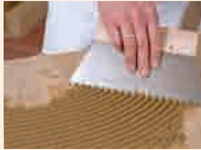
3 Beispiel einer Innendämmung: Auftrag von Lehmkleber auf die Rückseite der Dämmplatte.
