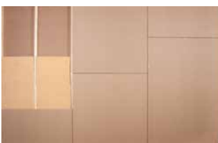
Plattenverlegung stehend
